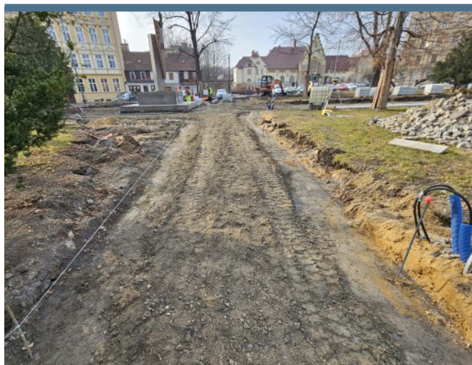
Przebudowa Placu Grunwaldzkiego
